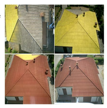
Possono essere impiegati prodotti impregnanti, che penetrano nel materiale legando le fibre di amianto tra loro e con la matrice cementizia, e prodotti ricoprenti, che formano una spessa membrana sulla superficie del manufatto. L'incapsulamento richiede necessariamente un trattamento preliminare della superficie del manufatto, al fine di pulirla e di garantire l'adesione del prodotto incapsulante
