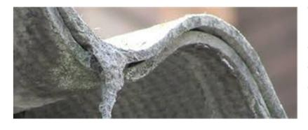
I principali indicatori utili per valutare lo stato di degrado delle coperture in cemento-amianto, in relazione al potenziale rilascio di fibre, sono: la friabilità del materiale; lo stato della superficie ed in particolare l'evidenza di affioramenti di fibre;
